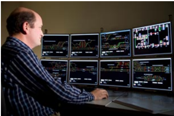
Arbeitsplatz mit aufgeschaltetem BZ-ESTW: In dieser Konfiguration kann die komplette Anlage von nur zwei Fahrdienstleitern gefahren werden.
